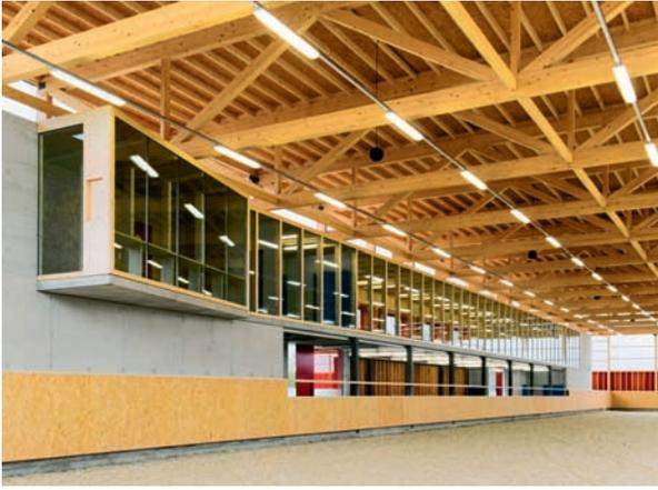
zelenen Platten wie auch deren Schraubenlöcher wurden mittels Lasertechnik nach den individuellen Plänen zugeschnitten und konfektioniert. Mit dem Laserzuschnitt werden die Kanten nicht nur veredelt, sondern auch versiegelt, sodass ein Eindringen von Flüssigkeit stark behindert wird.
