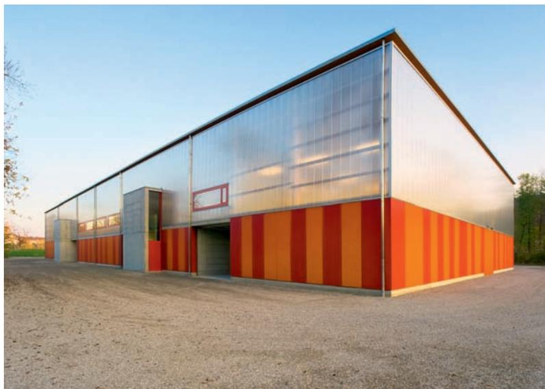
Die Holzbaustruktur der neuen Reithalle im Aarauer Schachen ist bis zu einer Höhe von 3,50 m (Sockelbereich) mit grossflächigen Holzwerkstoffplatten (Formboard) verkleidet. Darüber sind Polycarbonatplatten angebracht (links), die bei Dunkelheit die illuminierte Halle wie einen Leuchtkörper (unten) erstrahlen lassen.
