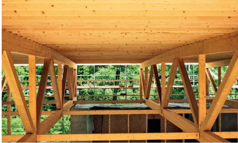
Die überhöht ausgebildeten Obergurte der \*BSB\*-Fachwerkträger (links) ergeben eine Dachneigung von 1,5%.
